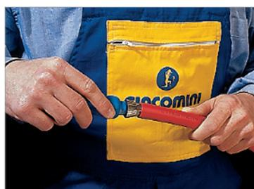
La perfetta tenuta dei raccordi a pressione meccanica è possibile solo se il tubo ed il raccordo hanno diametri e spessore nominali corrispondenti. Onde evitare assemblaggi non corretti, pertanto, è opportuno controllare le dimensioni dei componenti prima di effettuare la pressatura.
